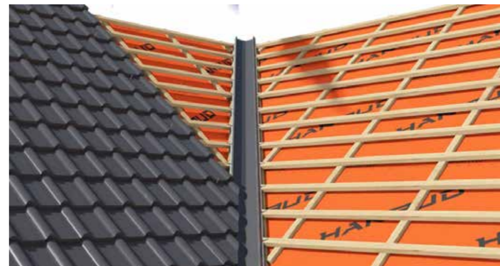
17 pav. Stogo čerpių lakštų klojimas prie stoglatakio – sąlajos
