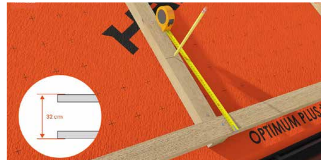
8 pav. Grebėstų montavimas ant stogo šlaito.
