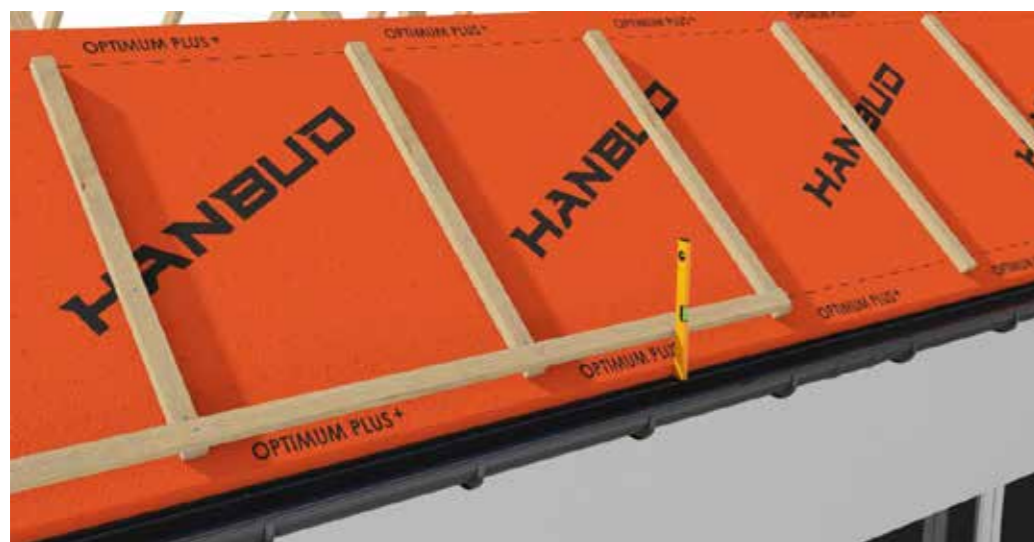
7 pav. Išilginių grebėstų montavimas ant stogo šlaito.
